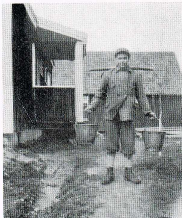
Før vannet ble innlagt.
